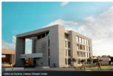
Edificio de Investigación, Campus Obregón Centro
