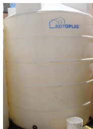
Figura 10. Cisterna de 20,000 litros de capacidad.
