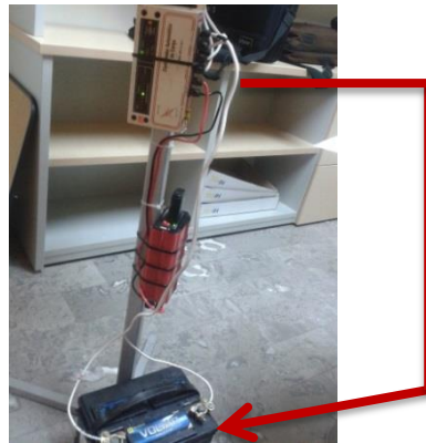
Figura 6. Uniones entre controlador de carga y batería.
