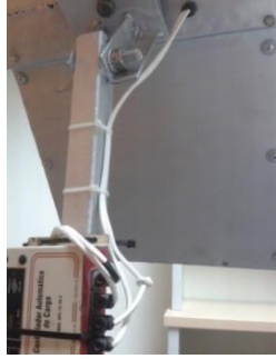
Figura 5. Conexión de paneles solares con controlador de carga.
