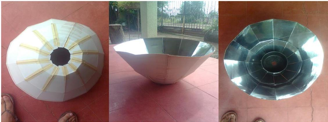
Figura 7. Construcción del panel reflejante estufa paraboloide de plana.
