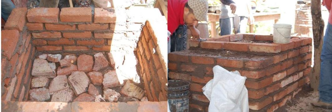
Figura 5. Relleno de la base con cascajo.
