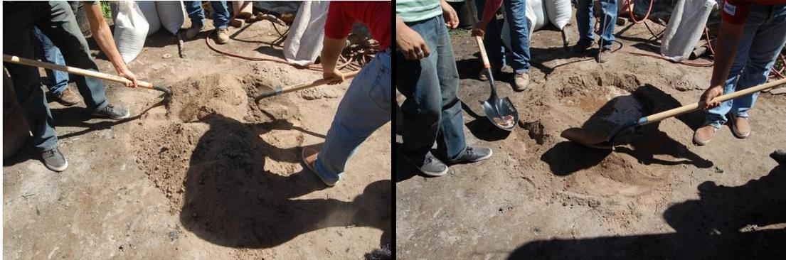
Figura 3. Preparación de la mezcla de lodo y arena.
