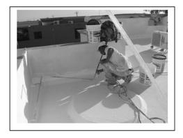
Figura 1. Impermeabilización de la losa de azotea.
