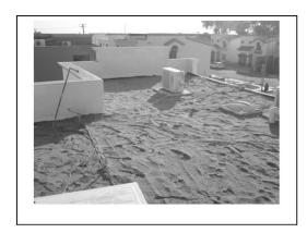
Figura 3. Colocación de la mezcla de limo, perlita y tierra de germinación en la Azotea.
